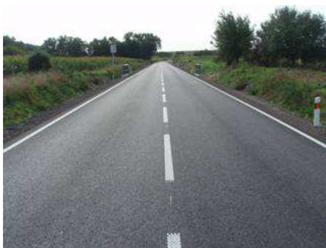
Stav po rekonstrukci
