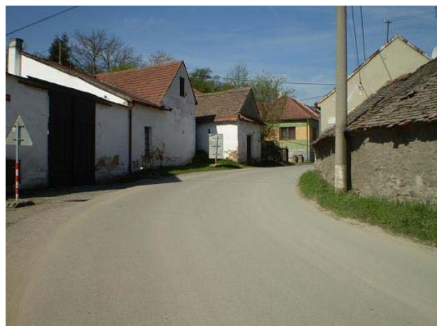
Stav před rekonstrukcí
