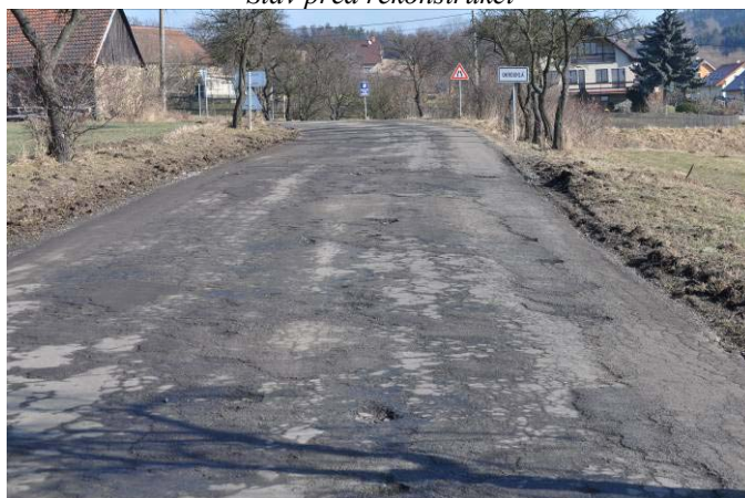
Stav před rekonstrukcí
