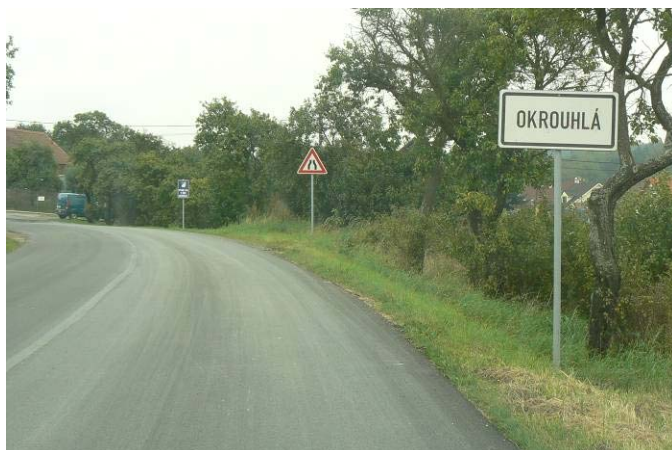
Stav po rekonstrukci
