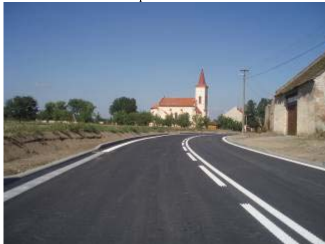
Stav po rekonstrukci
