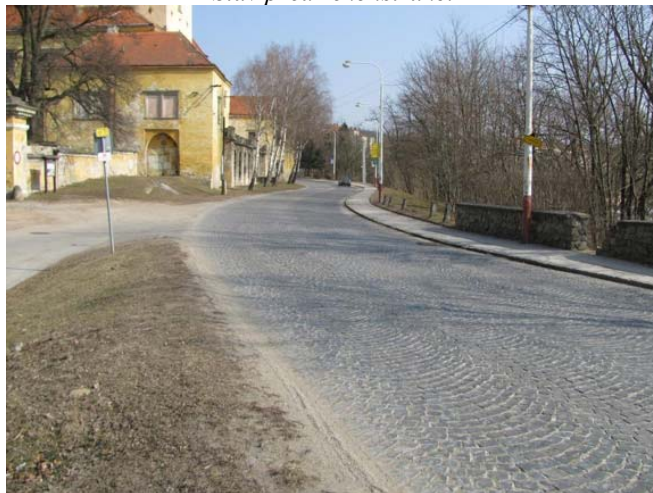
Stav před rekonstrukcí
