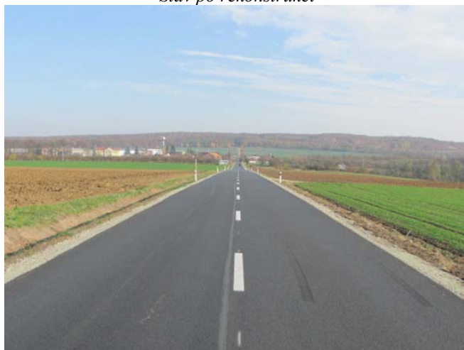
Stav po rekonstrukci
