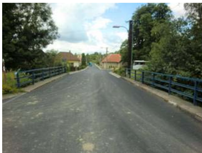
stav po rekonstrukci
