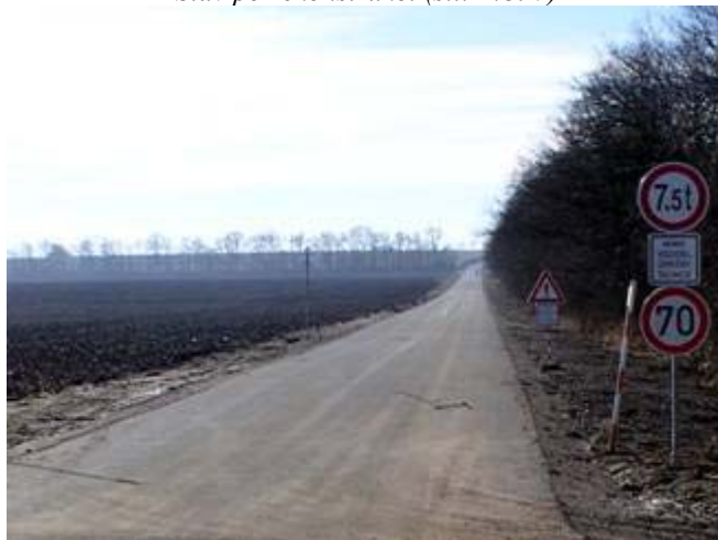
Stav po rekonstrukci (sil. II/397)
