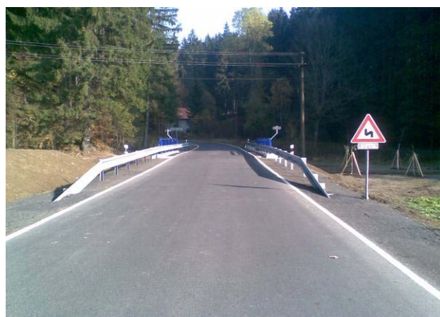
Stav po rekonstrukci
