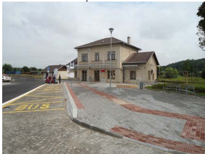
Stav po rekonstrukci
