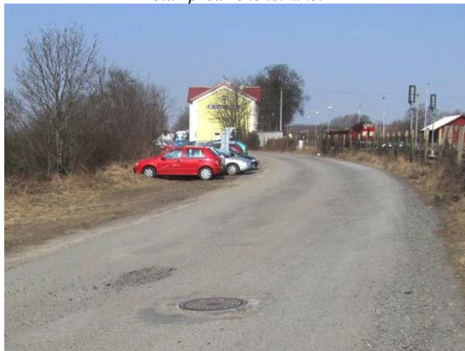
Stav před rekonstrukcí
