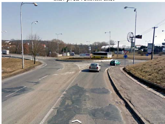
Stav před rekonstrukcí
