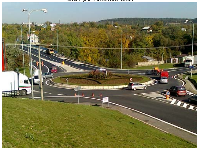
Stav po rekonstrukci
