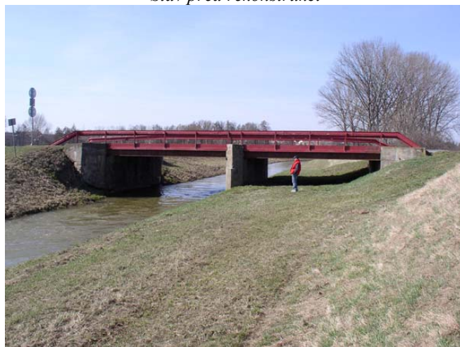
Stav před rekonstrukcí
