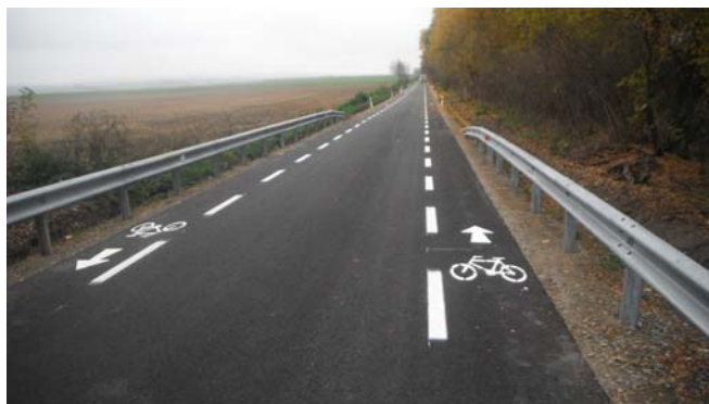
Stav po rekonstrukci
