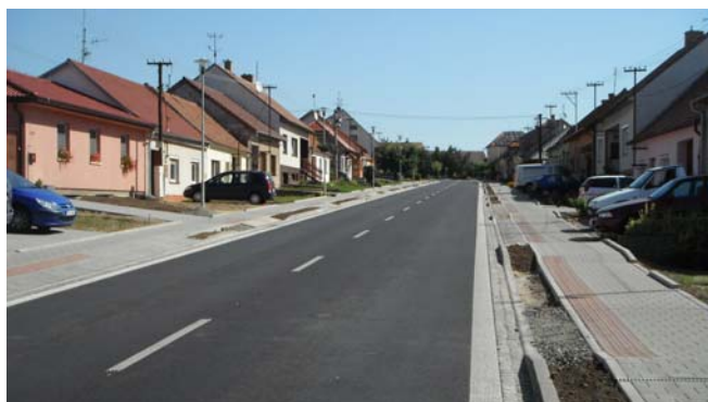
Stav po rekonstrukci
