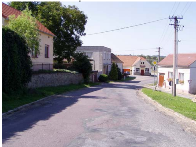
Stav před rekonstrukcí
