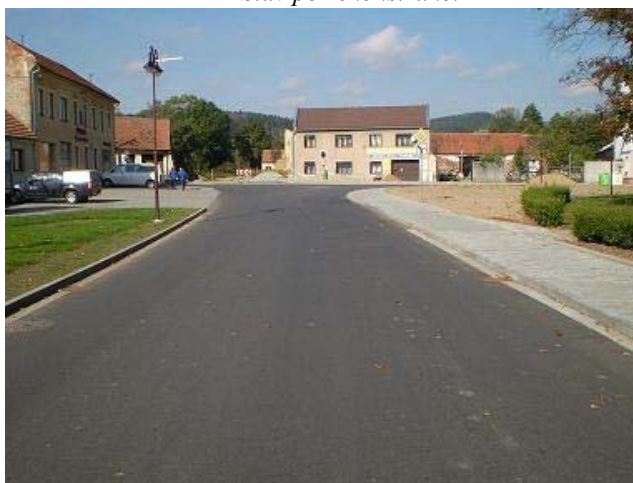
Stav po rekonstrukci
