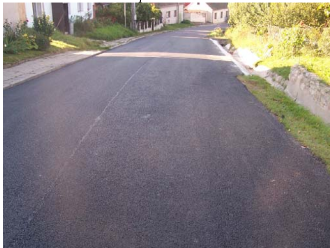
Stav po rekonstrukci
