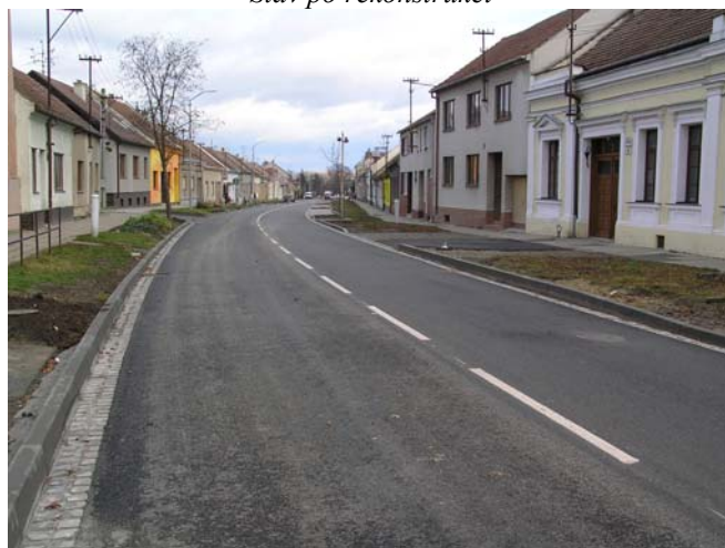
Stav po rekonstrukci
