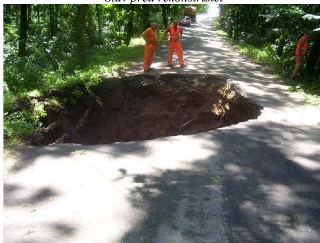
Stav před rekonstrukcí
