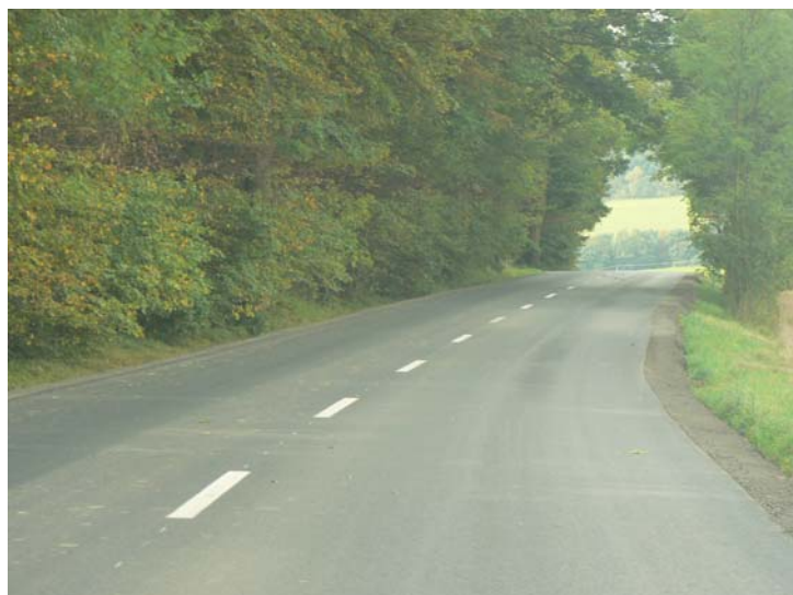
Stav po rekonstrukci
