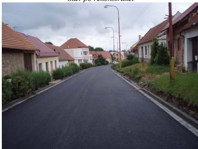
Stav po rekonstrukci
