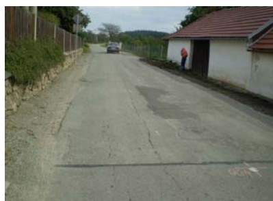
Stav před rekonstrukcí
