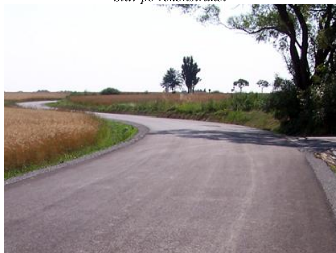
Stav po rekonstrukci
