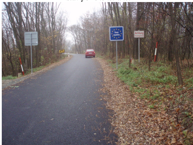
Stav po rekonstrukci
