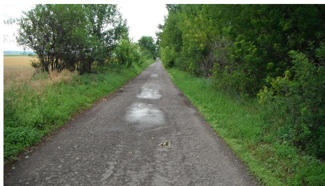
Stav před rekonstrukcí
