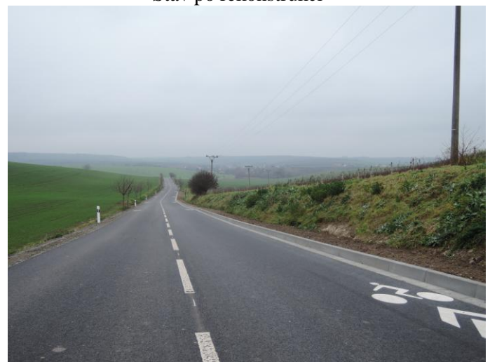
Stav po rekonstrukci
