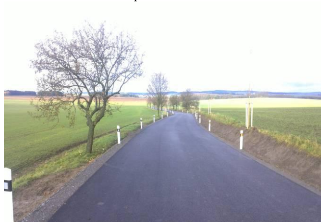
Stav po rekonstrukci
