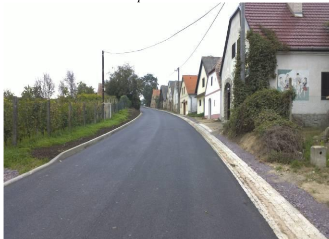
Stav po rekonstrukci
