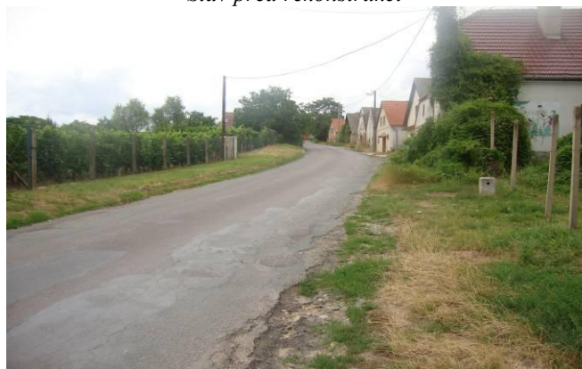
Stav před rekonstrukcí
