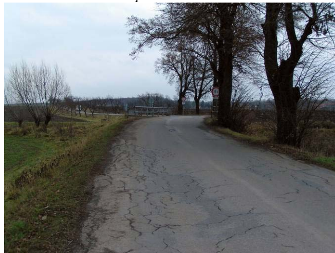
Stav před rekonstrukcí
