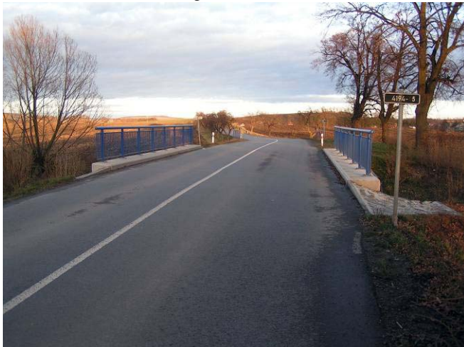
Stav po rekonstrukci
