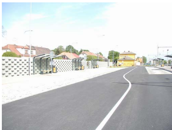
Stav po rekonstrukci
