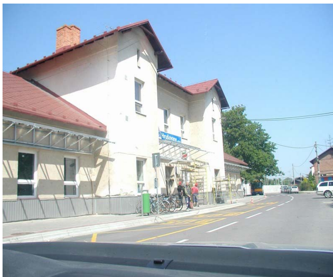
Stav po rekonstrukci
