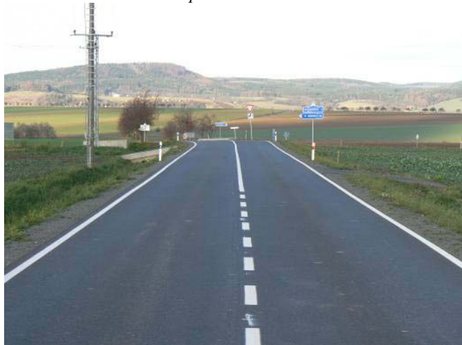
Stav po rekonstrukci
