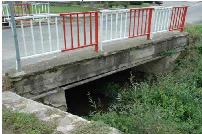
Stav před rekonstrukcí
