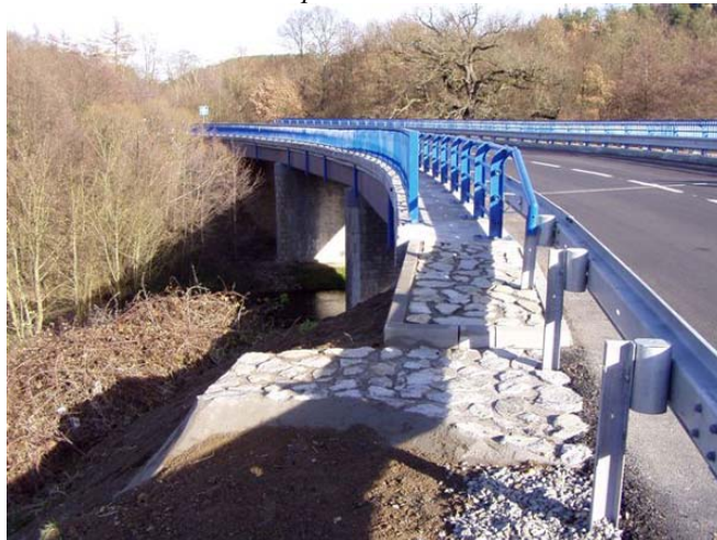
Stav po rekonstrukci
