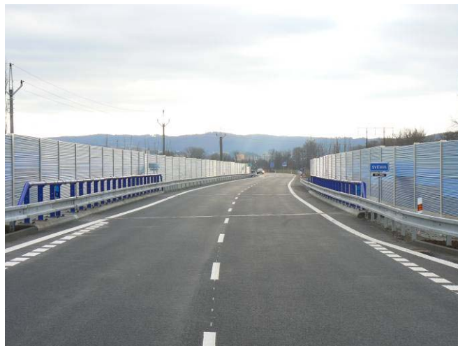
Dokončená stavba – most přes Svitavu, protihlukové stěny
