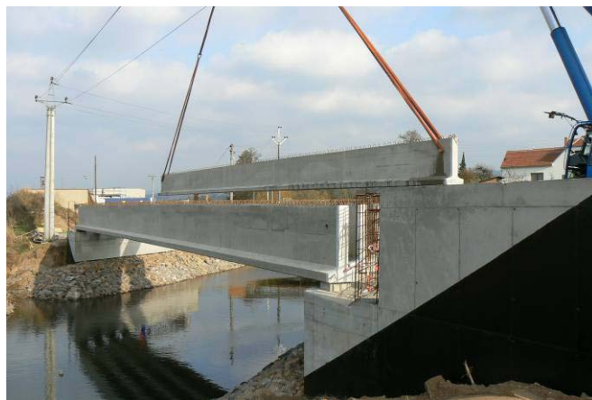
Průběh výstavby – most přes řeku Svitavu
