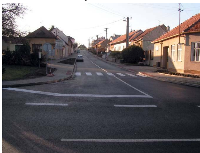
Stav po rekonstrukci
