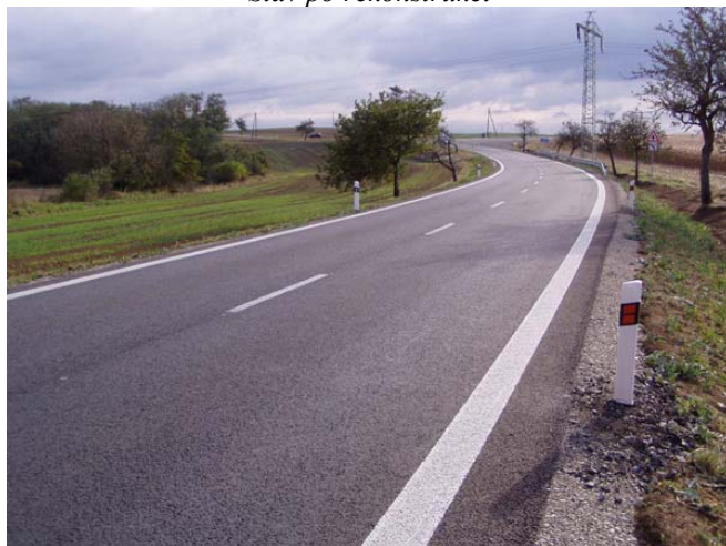
Stav po rekonstrukci
