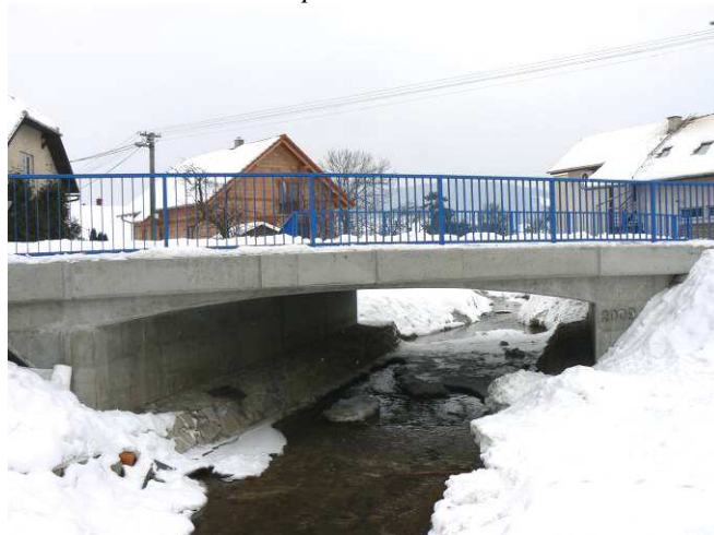
Stav po rekonstrukci
