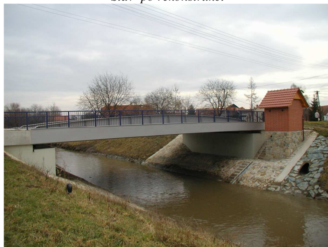
Stav po rekonstrukci
