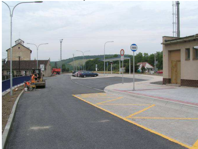
Stav po rekonstrukci
