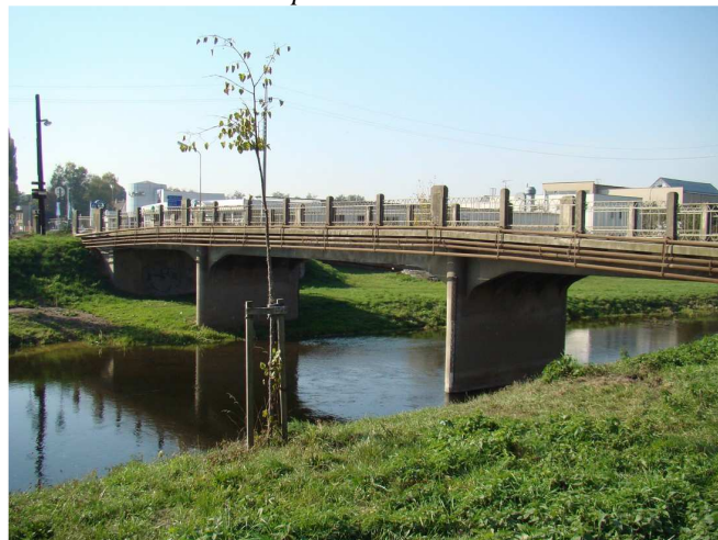
Stav před rekonstrukcí
