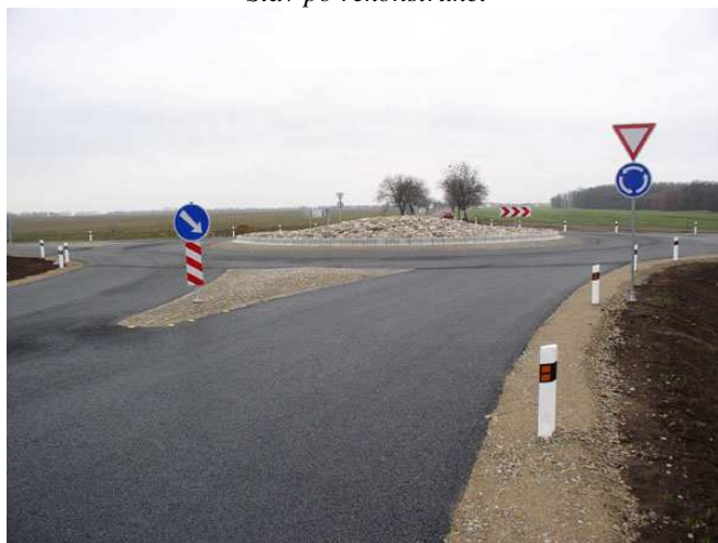
Stav po rekonstrukci
