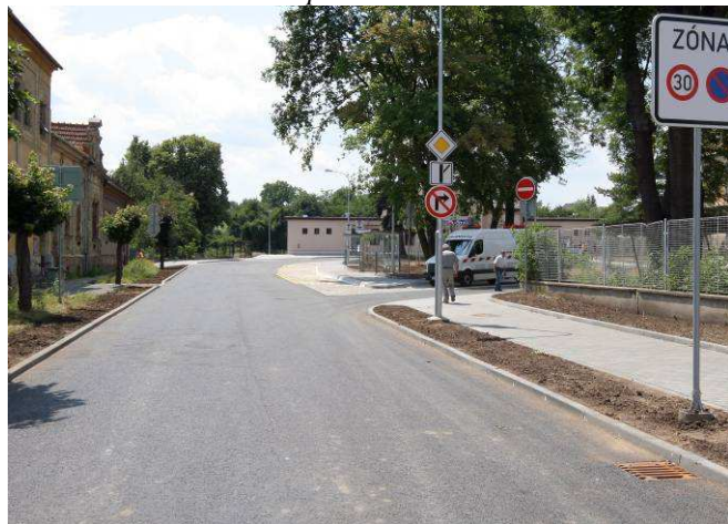
Stav po rekonstrukci
