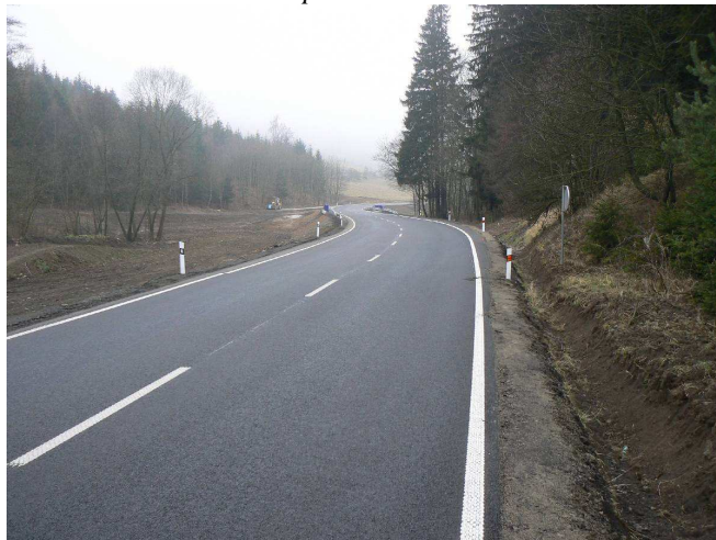
Stav po rekonstrukci
