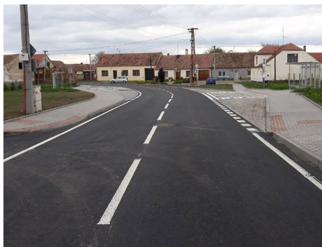
Stav po rekonstrukci
