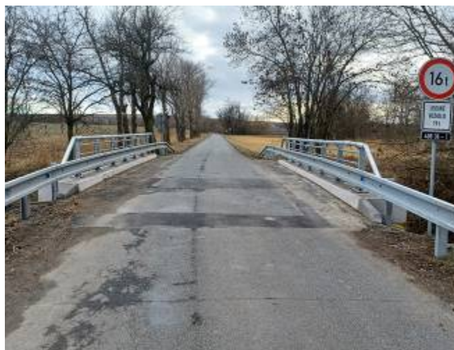
Stav po rekonstrukci
