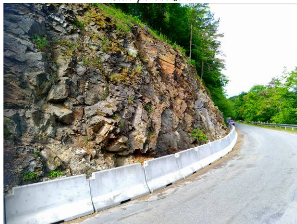
Stav po osazení
