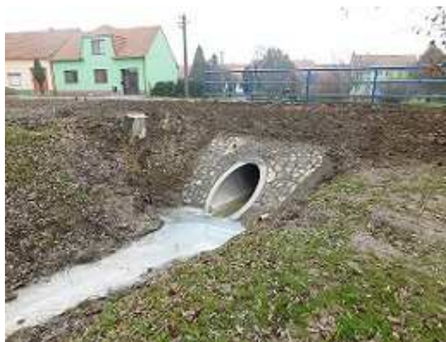
Stav po rekonstrukci
