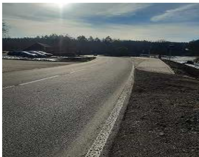
Stav po rekonstrukci
